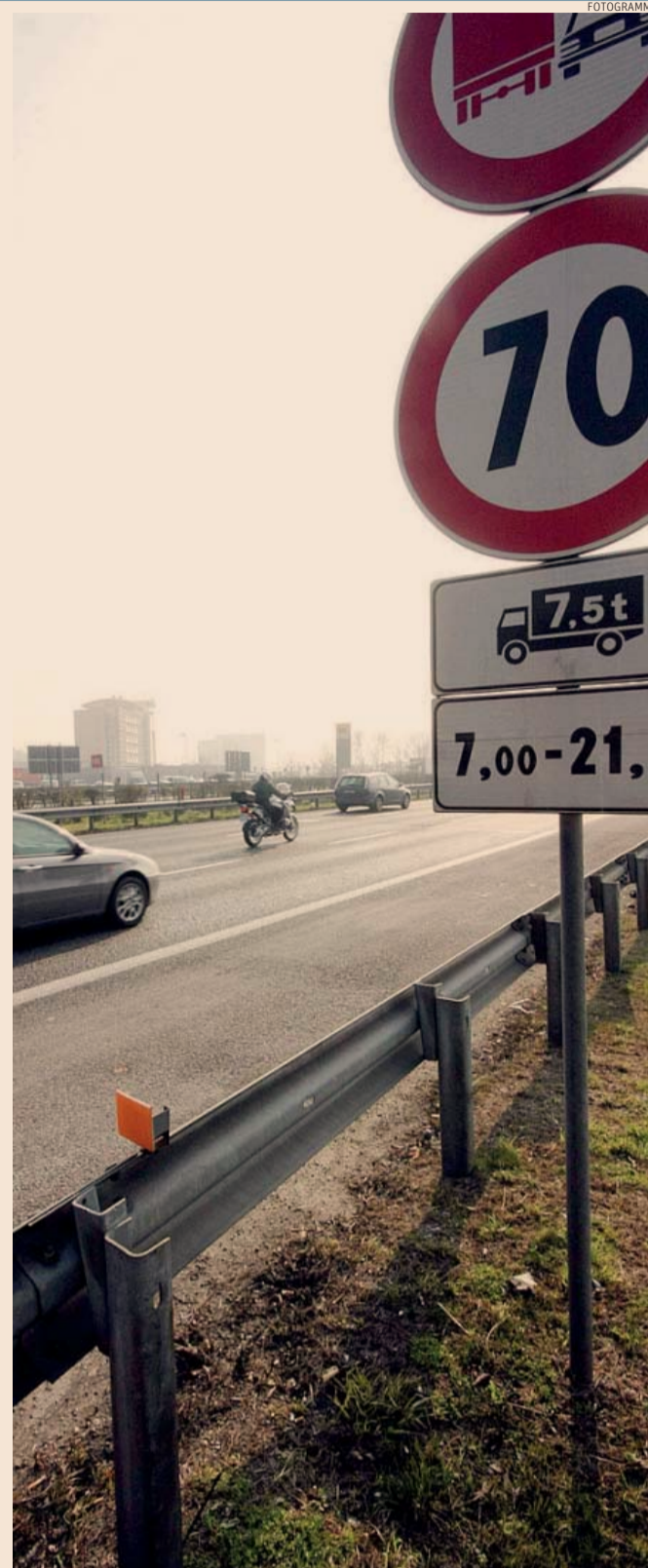
A doppia onda. Un guard-rail modello M100, datato ma ancora in uso
